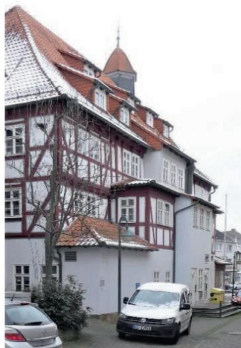
Rückansicht des Rathauses in Immenhausen. Hier ist die Installation eines Fahrstuhles zur barrierefreien Erschließung vorgesehen (Foto: H. Rössel)
